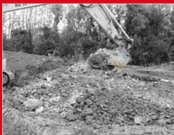
Dalsze przemieszanie gruntu ze środkiem wiążącym, przy jednoczesnym napowietrzaniu
