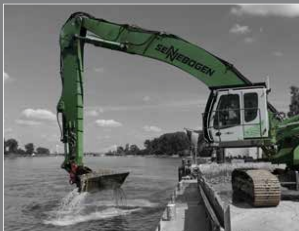
Wykopywanie toru wodnego
