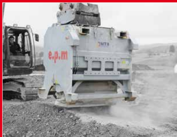
Łatwe rozprowadzanie środka wiążącego
