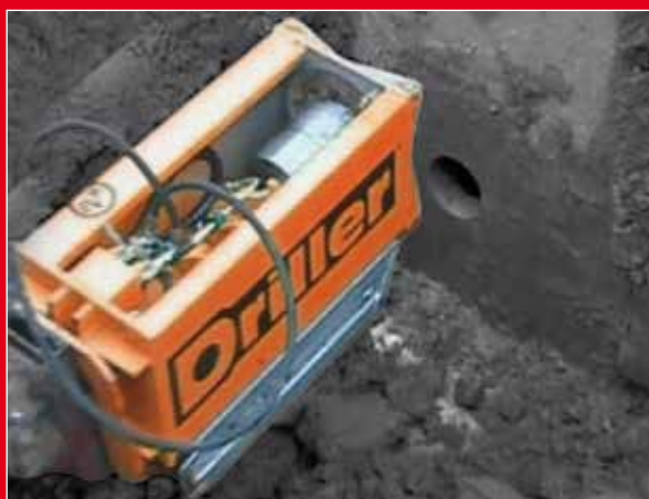
Wiercenie otworów poziomych w ścianach
