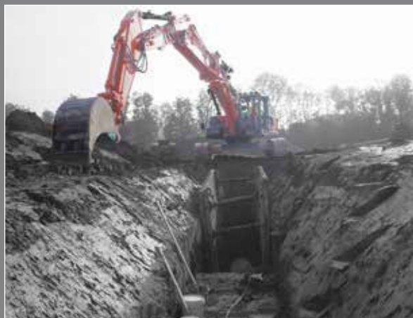
Budowa kanałów i układanie przewodów za pomocą koparki specjalnej
