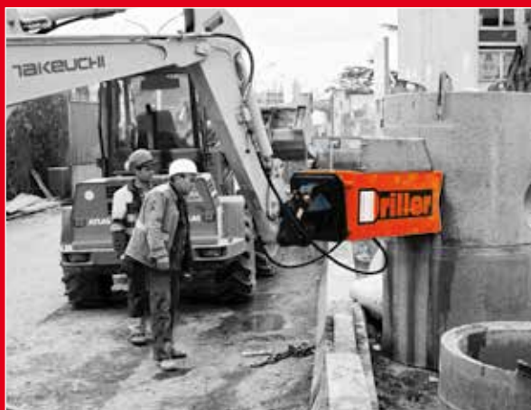
Wiercenie otworów poziomych w kanałach
