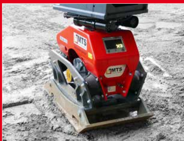
Zagęszczanie ulepszonego gruntu
