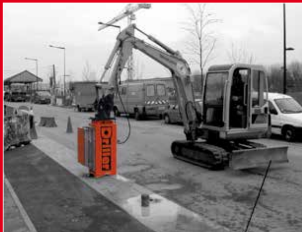
Wiercenia w ramach układania instalacji drogowych
