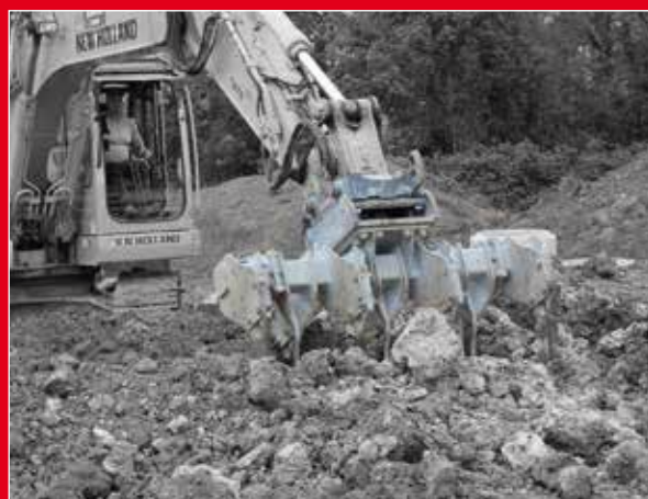
Rozprowadzanie wapna w gruncie
